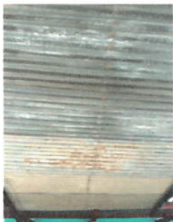
Foto 1: CUBIERTA DE LAMINA
