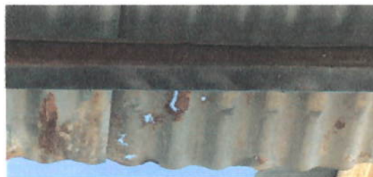
Foto 2: ESTRUCTURA DE TECHO
